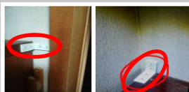
(A)タンスのL金具固定
