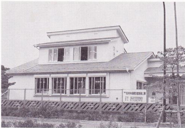
建設中の町内会館
